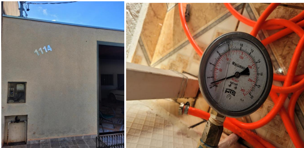
Figura 19 e 20: Residência N° 1114, avenida José Salustiano dos Santos.
