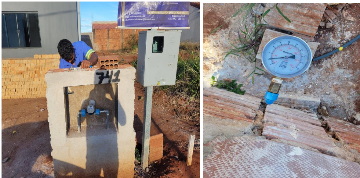
Figura 15 e 16: Residência Nº 741, avenida Juca Almeida.
